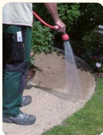
Schottertragschicht anfeuchten
