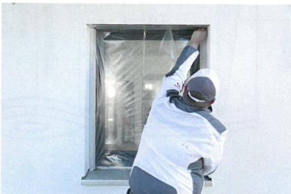
Stufenlos nach rechts auf die gewünschte Breite ziehen und mit dem Klebestreifen ankleben. Abschließend die mittlere Haftzone andrücken.
