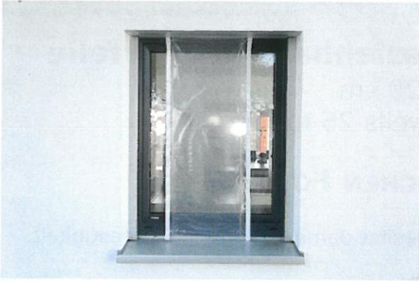
ZITRA-FOL mittig auf die Fensterbank legen, bei den Faltungen senkrecht nach oben ziehen, mittels seitlicher Klebestreifen ankleben und unten abschneiden.
