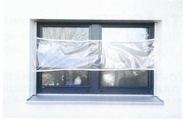
ZITRA-FOL mit beiden Klebekanten ca. 20 cm links ankleben, nach rechts ausrollen und abschneiden.
