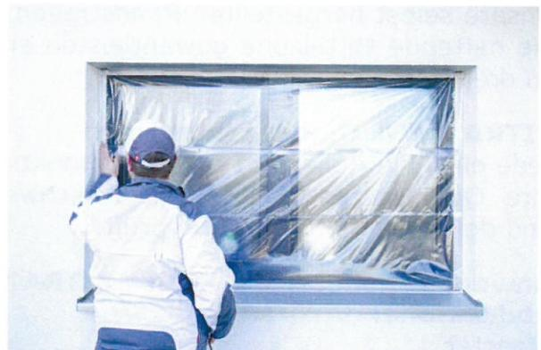
...bringen Sie den unteren Klebestreifen an der Fensterbankkante an und drücken die mittlere Haftzone fest.
