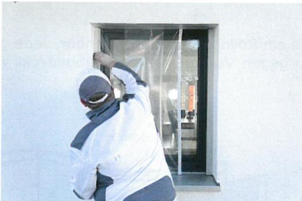
Zuerst nach links ziehen und mit dem Klebestreifen ankleben.
