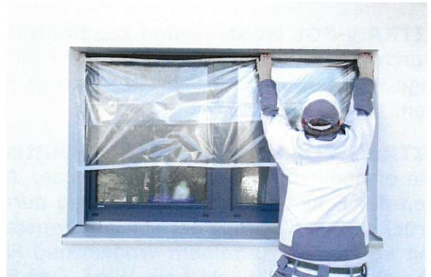
Fixieren Sie die Folie zuerst oben am Fenster und ziehen Sie diese dann auf die gewünschte Länge nach unten,....
